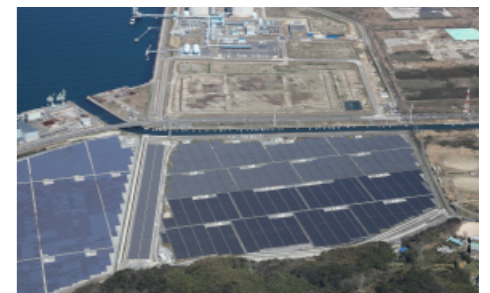
㉔ エネ・シードひびき太陽光発電所 発電規模：22.4MW
