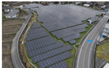
⑮ エネ・シード朝倉太陽光発電所 発電規模：1.3MW
