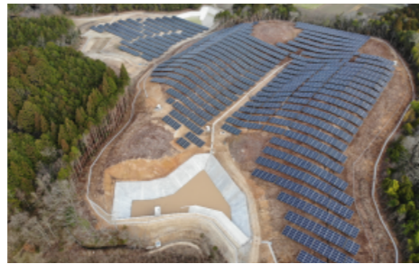
⑫ エネ・シード京都南丹太陽光発電所 発電規模：2.7MW
