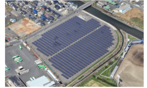
④ エネ・シード響南太陽光発電所 発電規模：1.7MW
