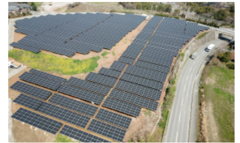
⑬ エネ・シード広川太陽光発電所 発電規模：1.6MW
